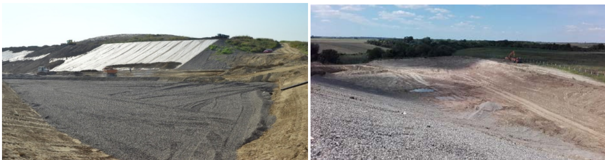
Slika 16. Radovi na I. i IV. fazi sanacije, 2016. godina
