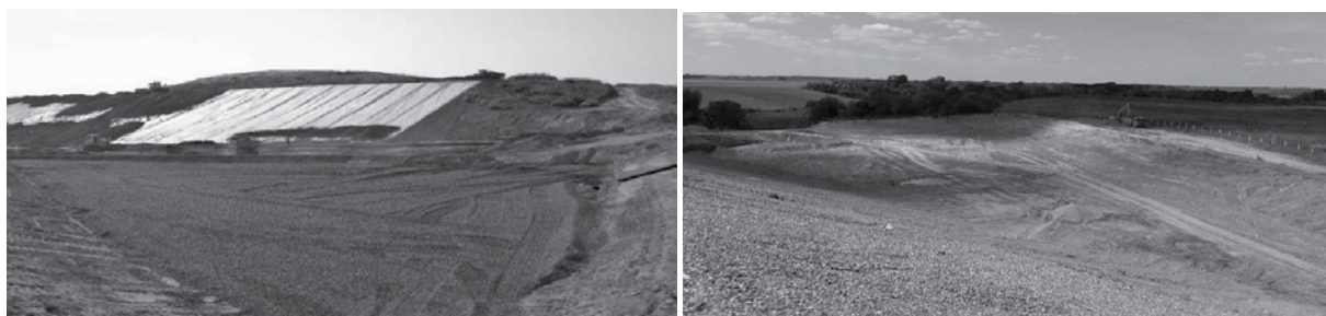
Slika 16. Radovi na I. i IV. fazi sanacije, 2016. godina
