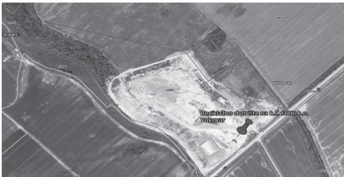
Slika 17. Lokacija izgrađenog reciklažnog dvorišta na k.č.6000 k.o. Vukovar
